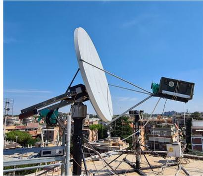
**Meccanica.** L'antenna, con la sua corretta installazione, è parte fondamentale di una stazione radio. Sicurezza ed efficienza dell'impianto non possono prescindere da valutazioni di resistenza alle condizioni ambientali e riduzione dei rischi nel caso di rotture o malfunzionamenti. Più grande è l'antenna migliori i collegamenti, ma in proporzione aumentano le difficoltà costruttive e di installazione
